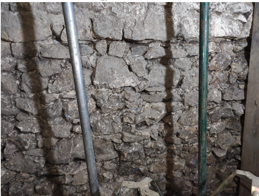
Fot. 2. Kraków, Wirydarz przy zakrystii kościoła św. św. Piotra i Pawła w Krakowie. Mury odkryte w toku archeologicznych badań wykopaliskowych prowadzonych w latach 2011-2021. Fragment wschodniego fundamentu kamienicy XIII/XIV w. od strony zewnętrznej (wschodniej). I. Jakubczyk 2021 r.
