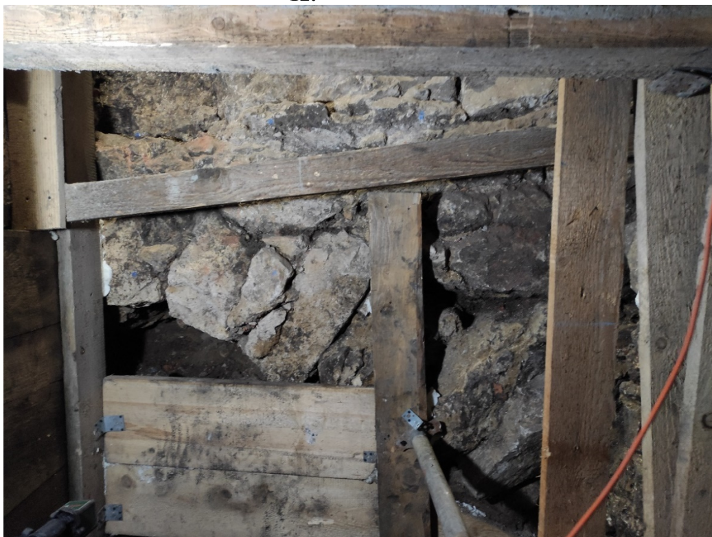
Fot. 12. Kraków, Wirydarz przy zakrystii kościoła św. św. Piotra i Pawła w Krakowie. Mury odkryte w toku archeologicznych badań wykopaliskowych prowadzonych w latach 2011-2021. Fragment łuku fundamentu odcinkowego kamienicy z XVI w., wnikaącego we wschodni fundament kościoła. I. Jakubczyk 2021 r.
