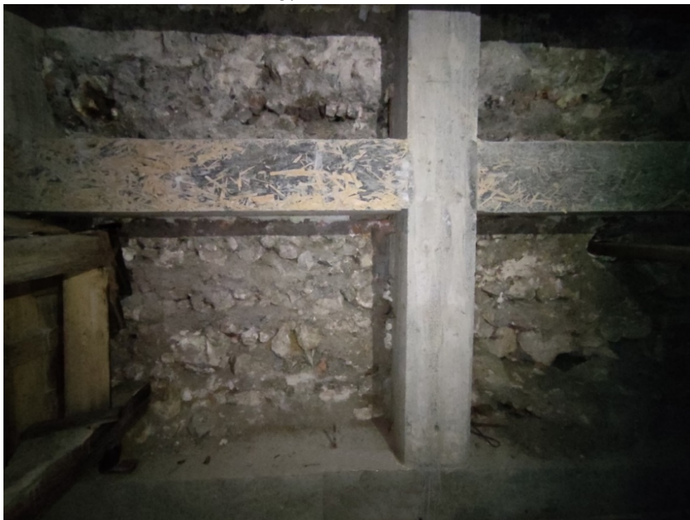
Fot. 13. Kraków, Wirydarz przy zakrystii kościoła św. św. Piotra i Pawła w Krakowie. Mury odkryte w toku archeologicznych badań wykopaliskowych prowadzonych w latach 2011-2021. Zachodnia powierzchnia fundamentu (XVI w.) odkrytego przez T. i K. Radwańskich oraz J. Poleskiego, wzmocnionego żelbetową konstrukcją, cz. północna. I. Jakubczyk 2021 r.
