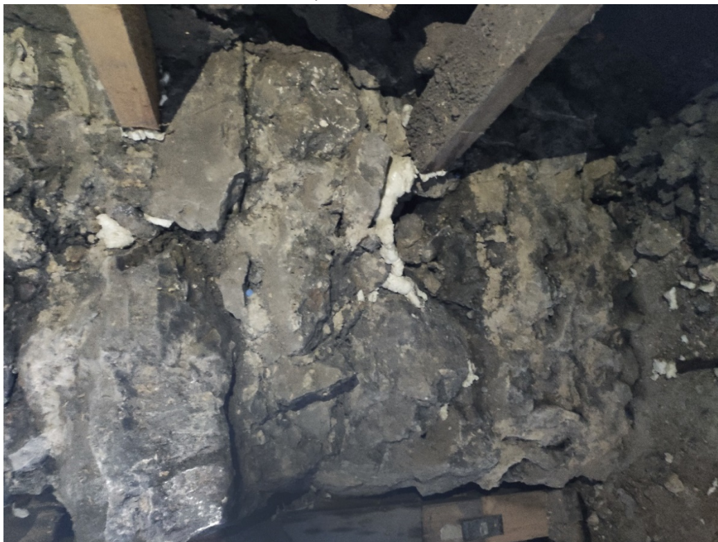
Fot. 11. Kraków, Wirydarz przy zakrystii kościoła św. św. Piotra i Pawła w Krakowie. Mury odkryte w toku archeologicznych badań wykopaliskowych prowadzonych w latach 2011-2021. Zniszczenia struktury jednego z filarów fundamentu odcinkowego kamienicy z XVI w. I. Jakubczyk 2021 r.
