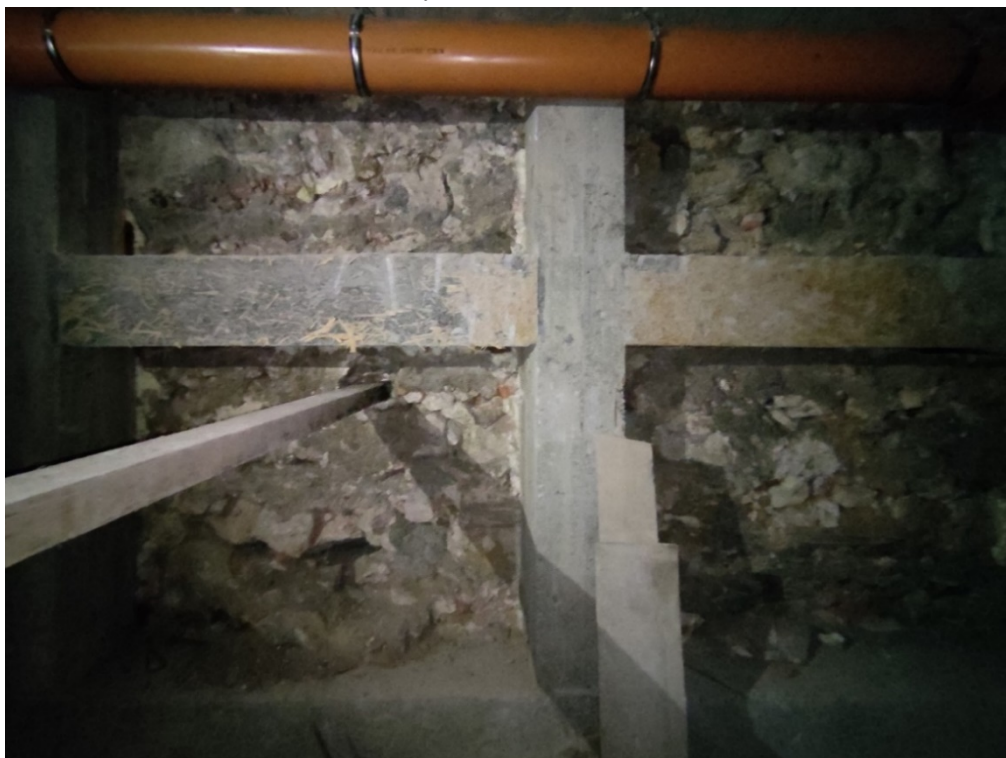
Fot. 14. Kraków, Wirydarz przy zakrystii kościoła św. św. Piotra i Pawła w Krakowie. Mury odkryte w toku archeologicznych badań wykopaliskowych prowadzonych w latach 2011-2021. Zachodnia powierzchnia fundamentu (XVI w.) odkrytego przez T. i K. Radwańskich oraz J. Poleskiego, wzmocnionego żelbetową konstrukcją, cz. środkowa. I. Jakubczyk 2021.
