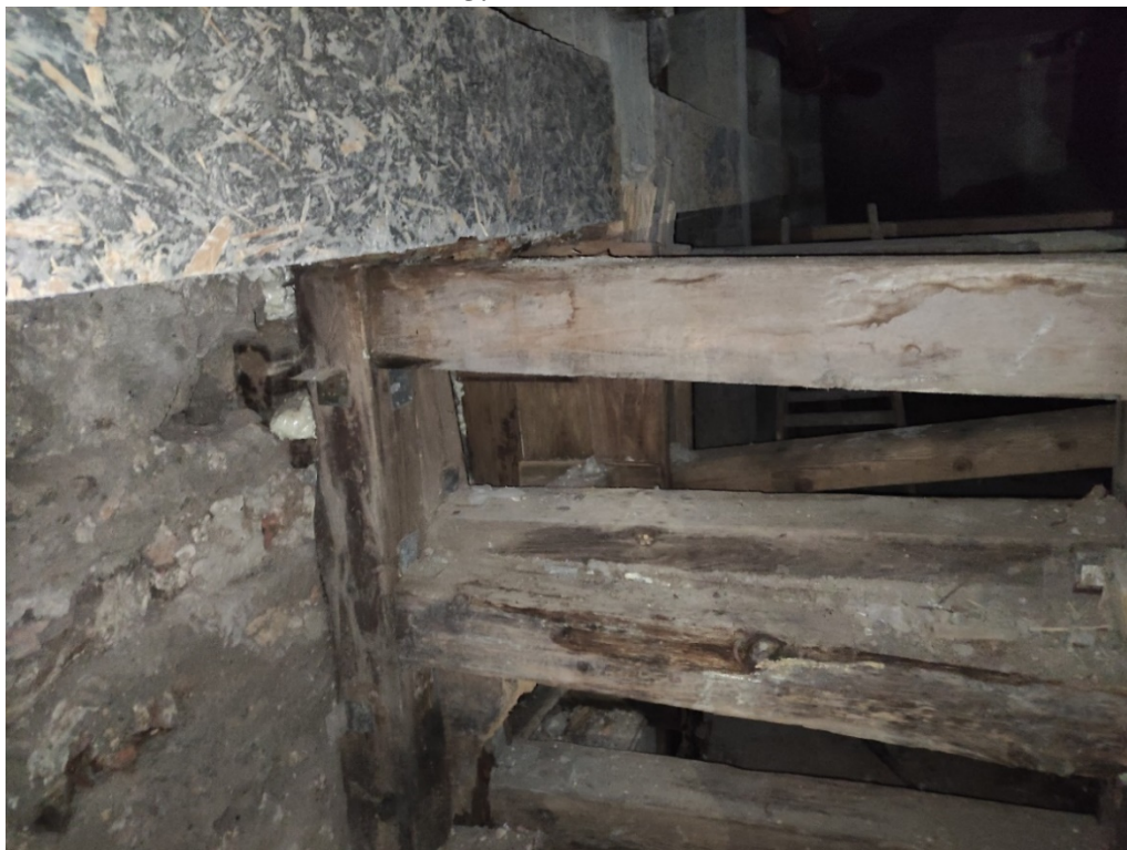
Fot. 15. Kraków, Wirydarz przy zakrystii kościoła św. św. Piotra i Pawła w Krakowie. Mury odkryte w toku archeologicznych badań wykopaliskowych prowadzonych w latach 2011-2021. Konstrukcje drewniane czasowo zabezpieczające lico fundamentu (XVI w.) odkrytego przez T. i K. Radwańskich oraz J. Poleskiego. I. Jakubczyk 2021 r.
