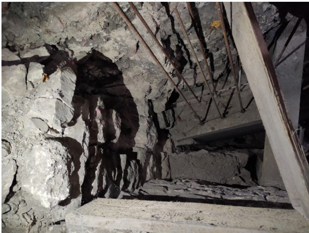
Fot. 7. Kraków, Wirydarz przy zakrystii kościoła św. św. Piotra i Pawła w Krakowie. Mury odkryte w toku archeologicznych badań wykopaliskowych prowadzonych w latach 2011-2021. Widok na wewnętrzne lico narożnika kamienicy XIII/XIV w. z rysującą się w dole odsadzką. I. Jakubczyk 2021 r.
