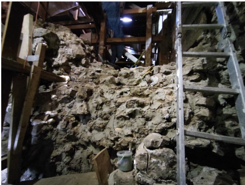
Fot. 5. Kraków, Wirydarz przy zakrystii kościoła św. św. Piotra i Pawła w Krakowie. Mury odkryte w toku archeologicznych badań wykopaliskowych prowadzonych w latach 2011-2021. Fragment wschodniego muru kamienicy XIII/XIV w. od strony zachodniej, ze zniszczonym licem, zabezpieczonym wstępnie zaprawą. I. Jakubczyk 2021 r.
