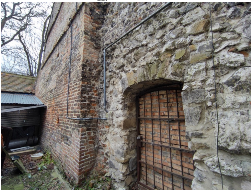
Fot. 22. Kraków, Wirydarz przy zakrystii kościoła św. św. Piotra i Pawła w Krakowie. Fragment kamienno-ceglanego muru (XVII-XVIII w.) łączącego NW narożnik wschodniego skrzydła klasztoru ss. Klarysek z narożnikiem kościoła, wraz zamurowanym otworem komunikacyjnym. I. Jakubczyk 2023 r.
